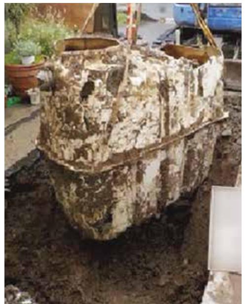
簡易浄化槽工事
