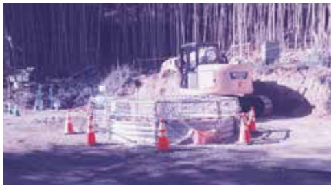
集水井作業現場 (深見)
